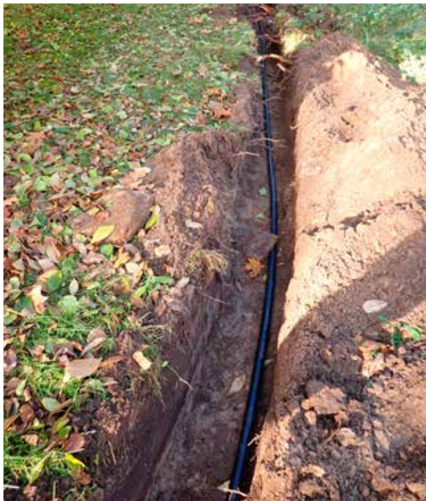
Figur 14. Översikt av OS200 längst med dammens södra sida. Nedlagd vattenledning är synlig. Mot väst. (Fotonr. 2025-07:10). Foto: Johanna Olsson.
